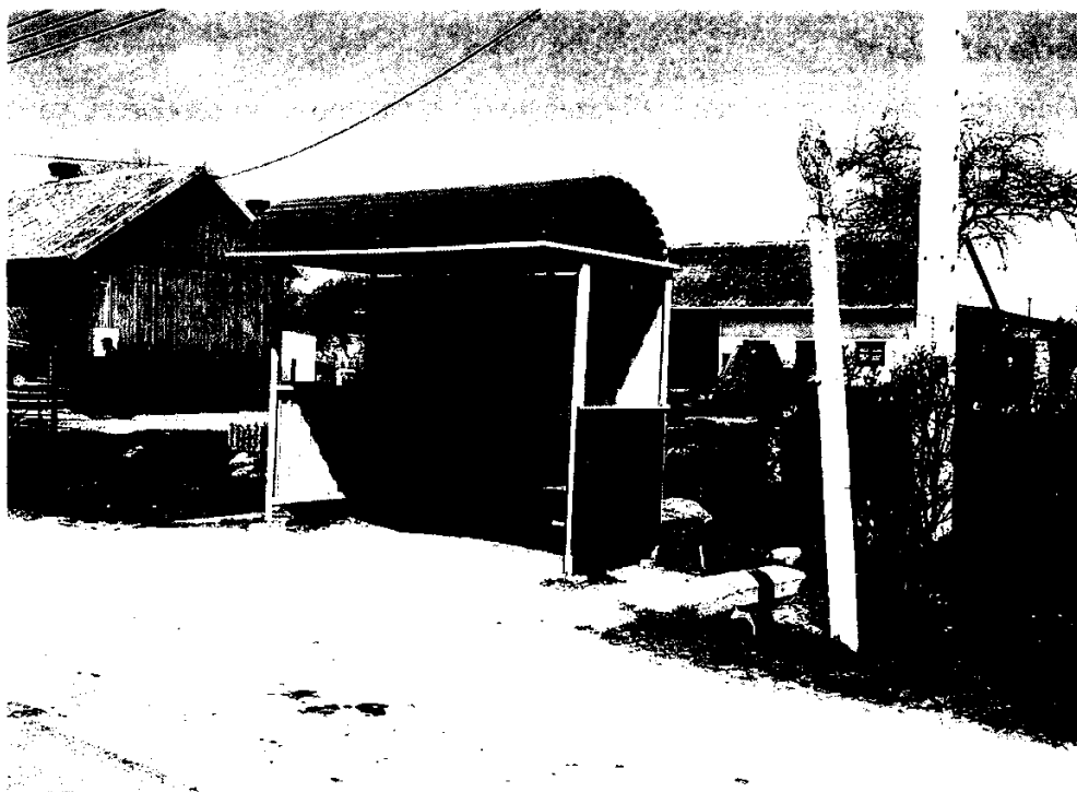
Zdjęcie 8. Przystanek autobusowy w Jaworze.
