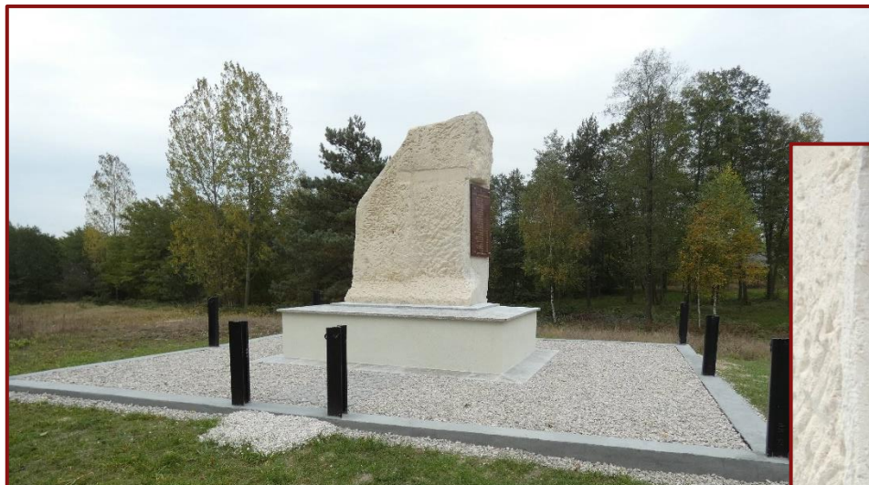
← Pomnik po remoncie w ramach pozyskanego grantu
