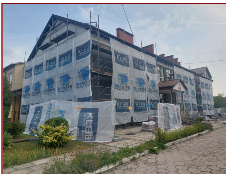
↑ Trwające prace termomodernizacyjne w Gminie Sobków
